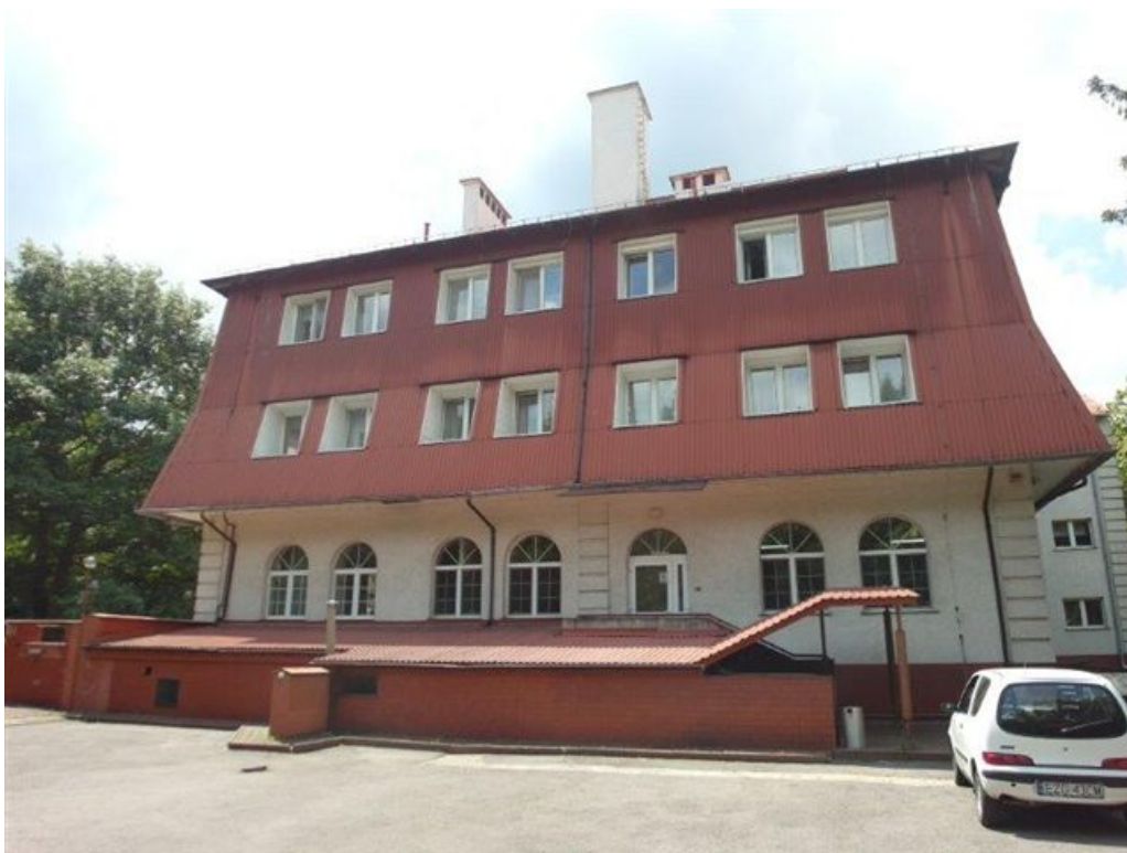
Fot. 2. Budynek Główny z kotłownią zasilającą obiekty DPS.
