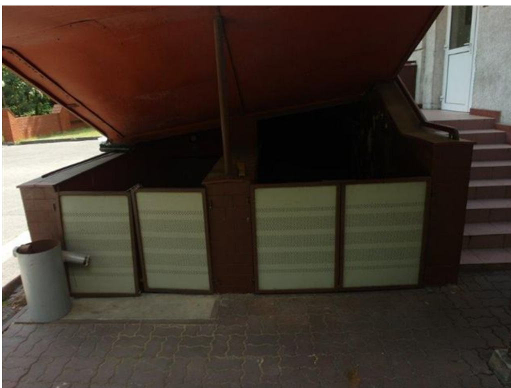
Fot.5. Wejście do istniejącej kotłowni- widok ogólny od strony tylnego wejścia Budynku Głównego
